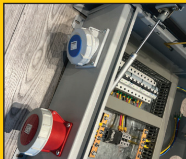
پروژه اورهال - مجتمع مس خاتون آباد
