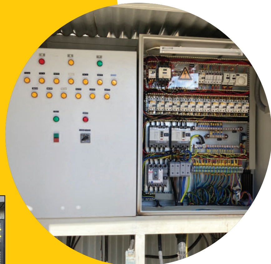
ساخت تابلو برق پروژه هیت تریسینگ مجتمع مس خاتون آباد
