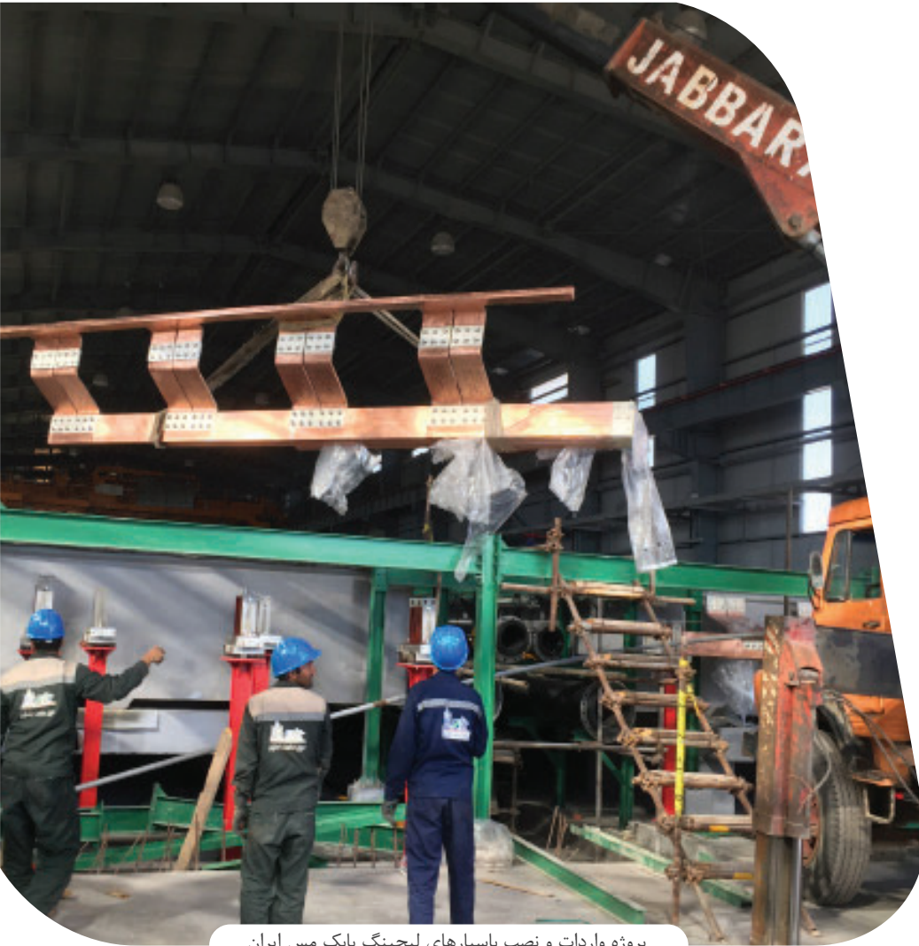
پروژه واردات و نصب باسبارهای لیچینگ بابک مس ایران
