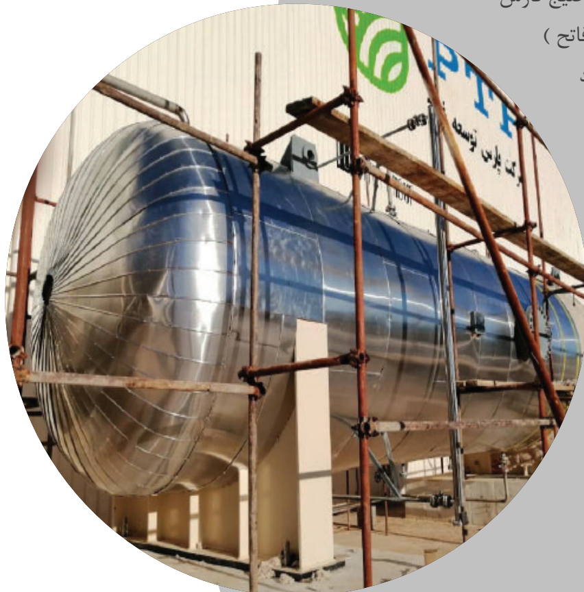
پروژه طراحی، تامین و اجرای هیت تریسینگ مخازن کارخانه پارس توسعه فاتح
