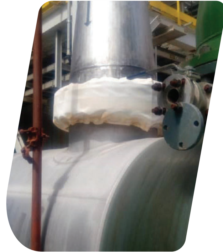
پروژه طراحی و دوخت کاور فلنجهای ضد اسید از جنس PP کارخانه اسید سرچشمه
