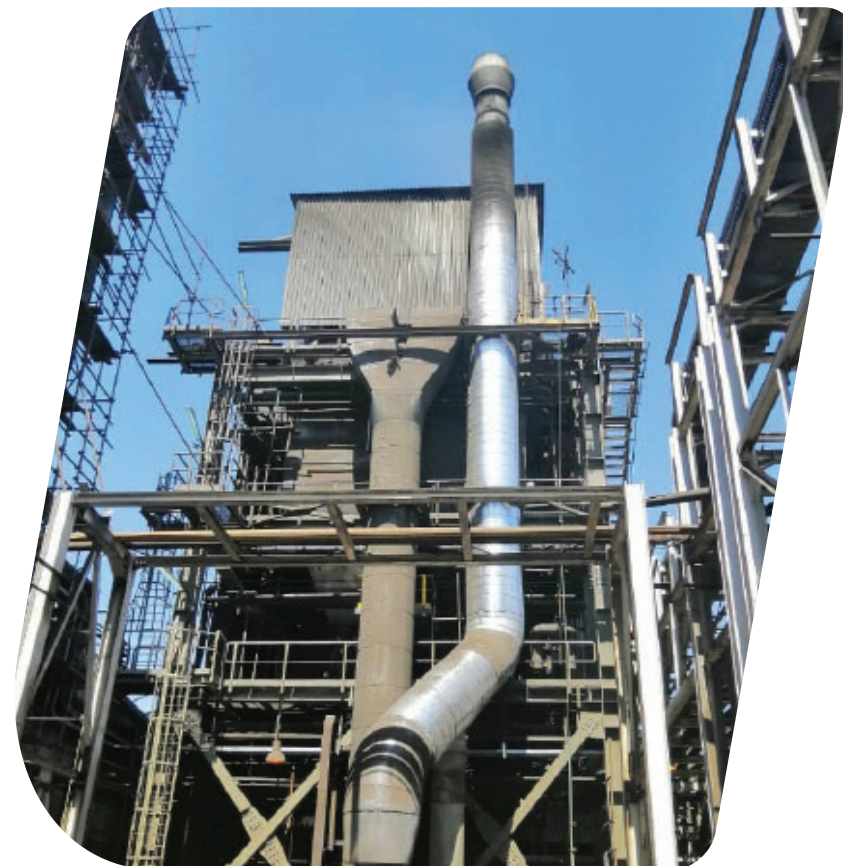
پروژه هیت تریسینگ و عایقکاری - کارخانه ذوب مجتمع مس خاتون آباد
